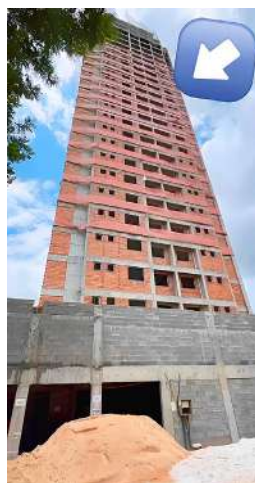
Figura 2 – Edifício Lis Tower Residência em construção
