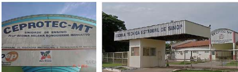
Figura 7 – Fachadas da Escola Técnica em 2004 e atual
